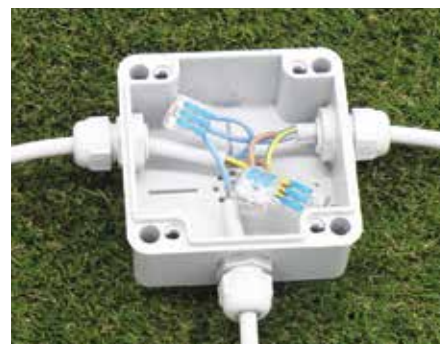
Cablare i cavi con i morsetti forniti nella confezione
