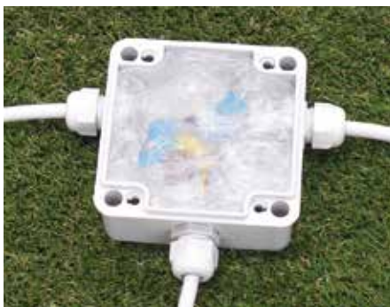
Lasciare un pò di gel in esubero per una perfetta aderenza al coperchio
