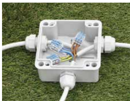
Cablare i cavi nella scatola di derivazione
