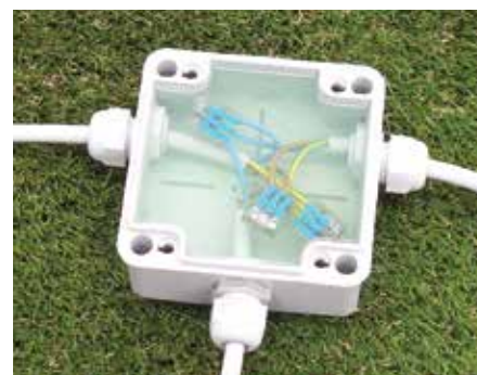
Attendere circa 15 minuti per la totale reticolazione poi chiudere il coperchio
