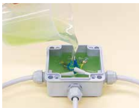
Colare il fluido miscelato all'interno della scatola fino a riempirla
