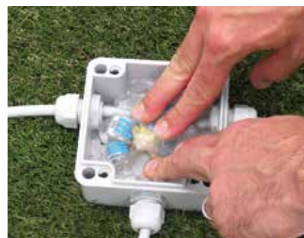
Ricoprire le connessioni, facendo attenzione a non lasciare zone di vuoto tra i contatti
