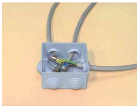
Cablare i cavi nella scatola di derivazione
