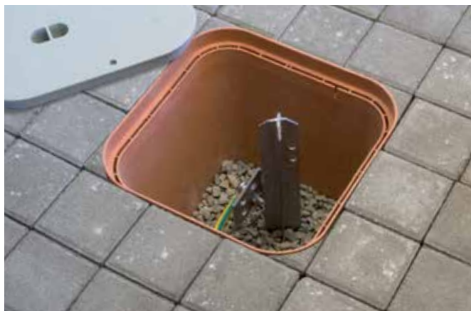
Installazione di un dispersore di terra Hearthring rod installation
